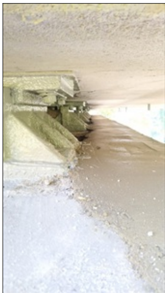
Pohled na ložiska opatřené PKO.
