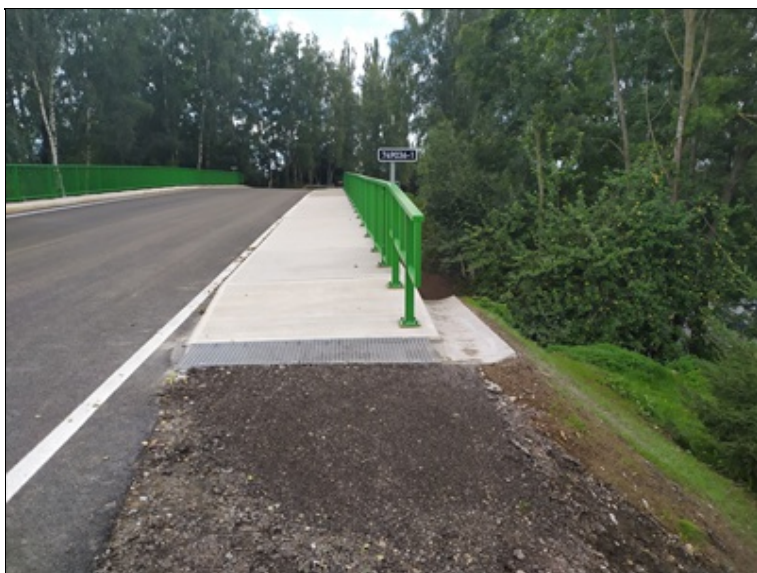
Pohled na levou chodníkovou římsu, nad skluzem proveden ocelový rošt.
