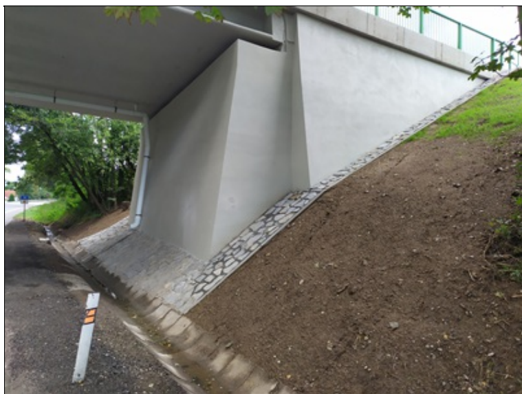
Pohled na opevnění kolem opěry 2.
