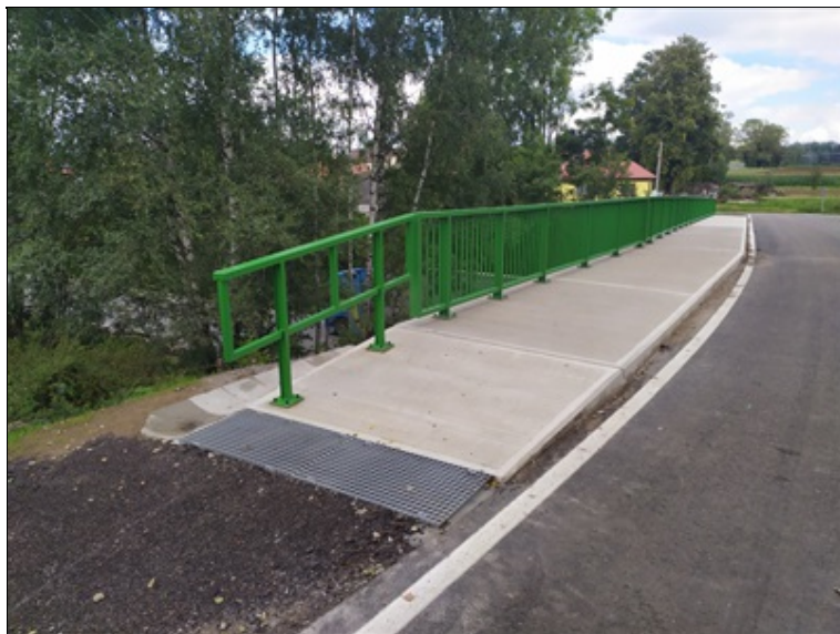
Pohled na rampovité ukončení římsy.
