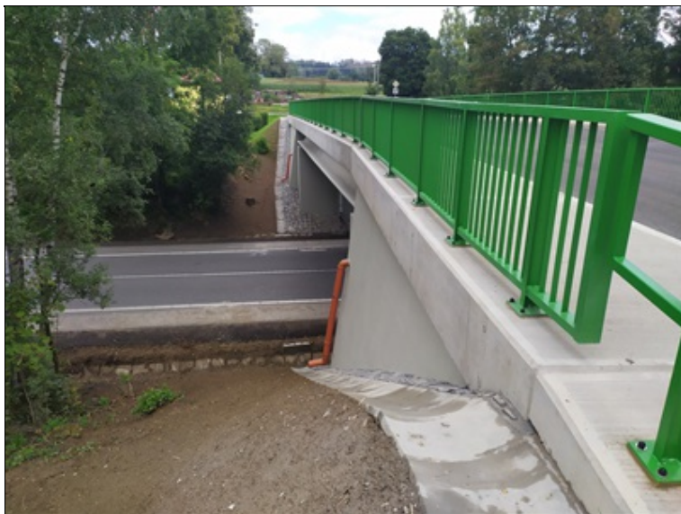
Pohled na římsu a zábradlí.
