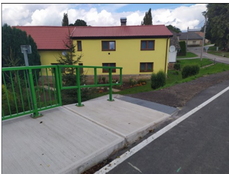
Pohled na silniční zábradlí na rampovitém ukončení římsy.
