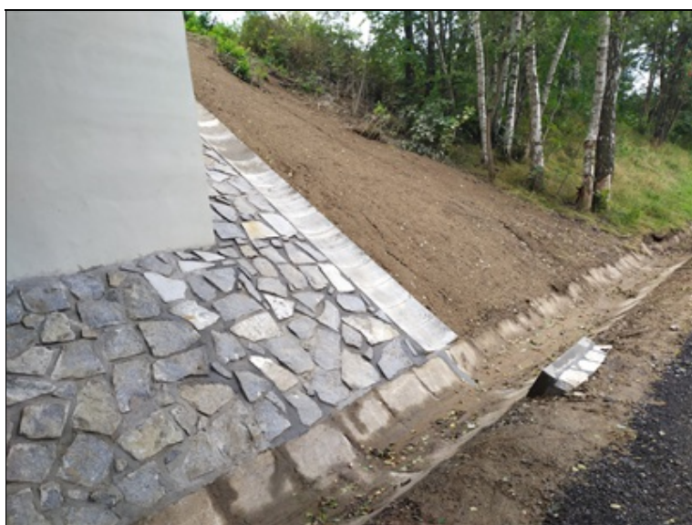
Pohled na opevnění pod mostem, kamenná dlažba do betonu.
