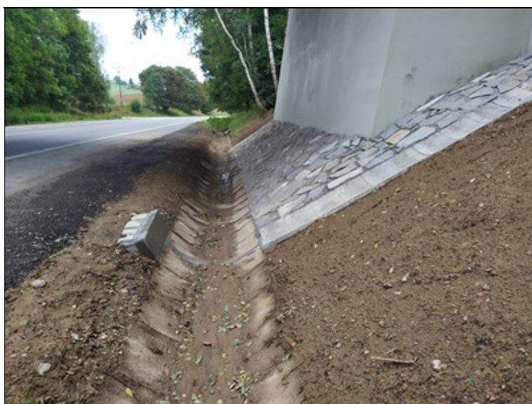
Pohled na rigol při silnici I/38
