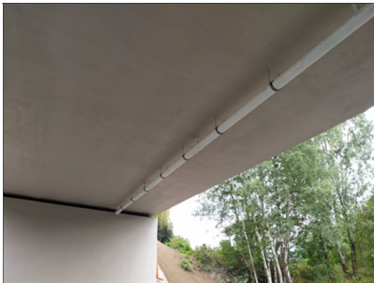
Pohled nosné konstrukce, podélný svod.
